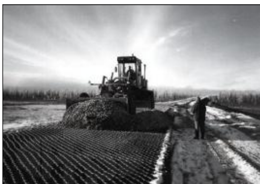
Rys. 8. Zasypywanie kruszywem komórek geosiatki za pomocą ładowarki
